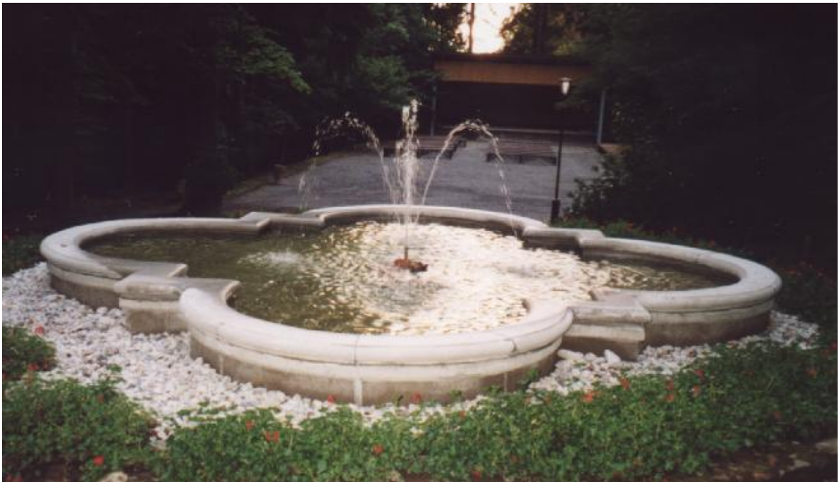
Bauvorhaben: Brunnenanlage an der Waldbühne Augustusburg
